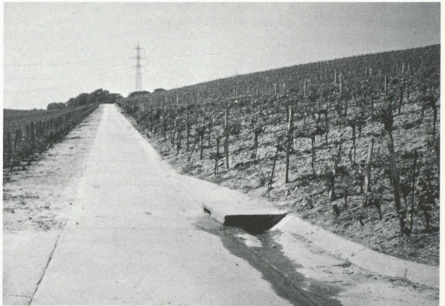
Fig. 2. — Chemin bétonné prévu pour l'interception de l'eau de ruissellement.
