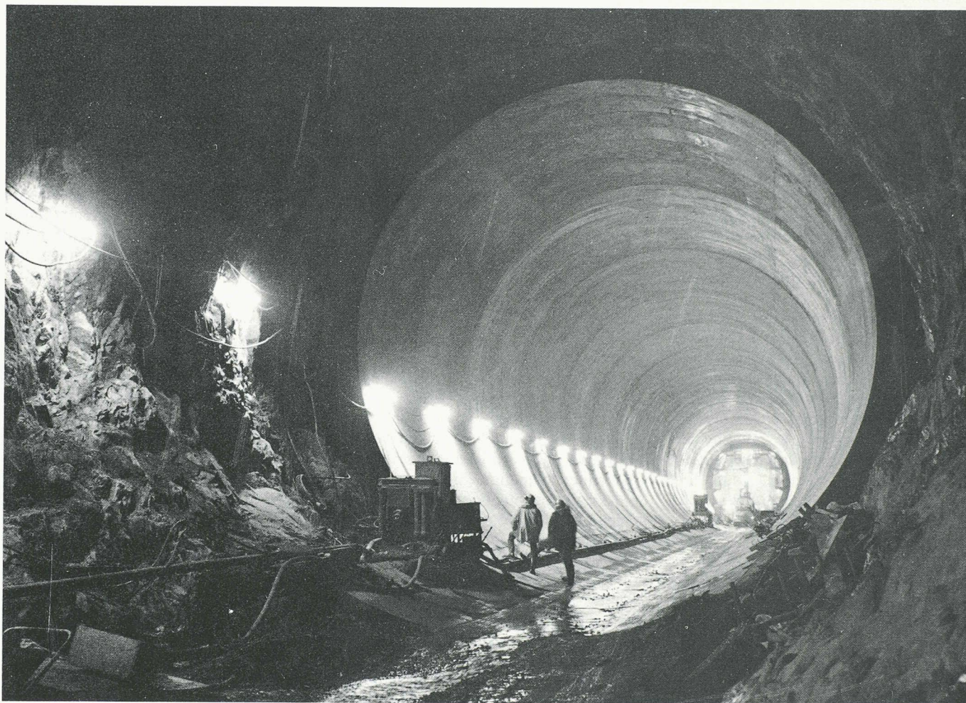
Travaux de génie civil en souterrain: galerie d'amenée d'un aménagement de pompage-turbinage à Dinorwic (Pays de Galles).
