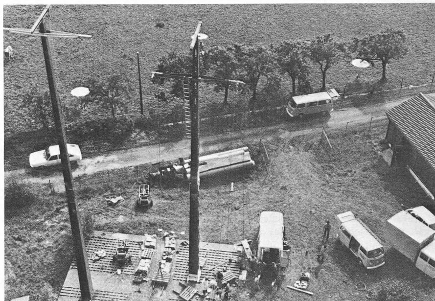
Fig. 4. — Plate-forme d'essai à Aigle.
