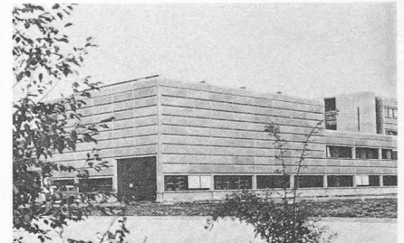
Fig. 1. — Halle d'essais des structures de l'EPFL à Ecublens.
