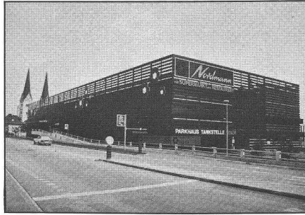
Parking à étages avec accès par rampes
