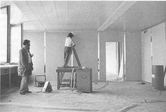
Fig. 10. — Montage des cloisons mobiles.
