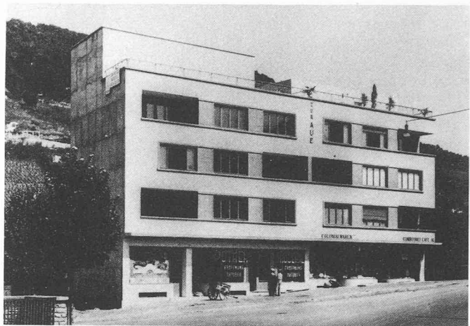
Fig. 14. — Immeuble «Zur Aue».
