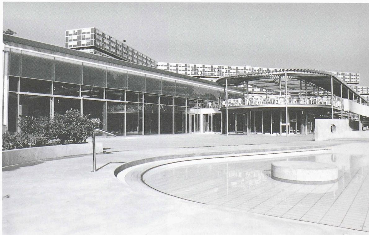
La couverture de celle-ci est constituée d'une tôle nervurée, de panneaux isolants de 120 mm et d'une étanchéité PVC type *Sarnafil*.
