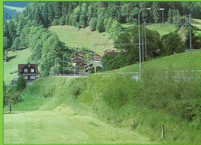
CH-Brunnadern, 1987; H = 6,0 m, L = 170 m; Ouvrage de soutènement pour l'élargissement de la chaussée
