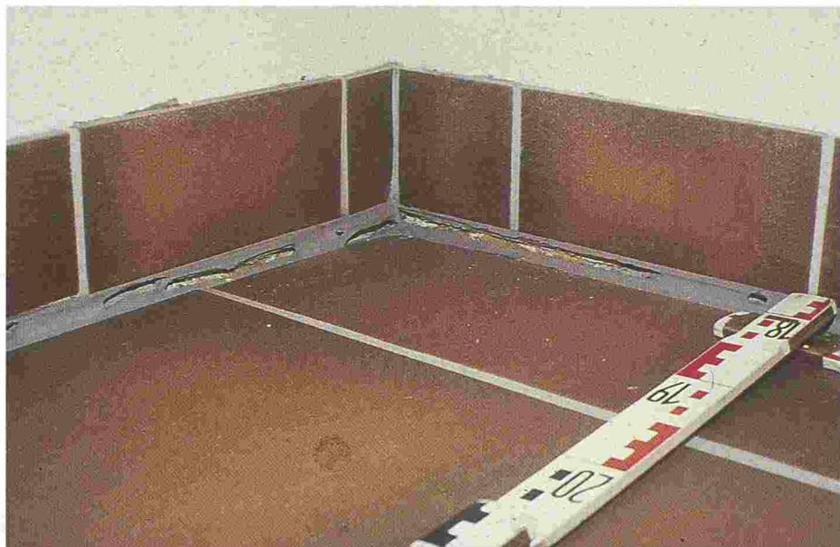
Fig. 2. – Contre-déformations, affaissement sur les bords et rupture du joint mastic.
