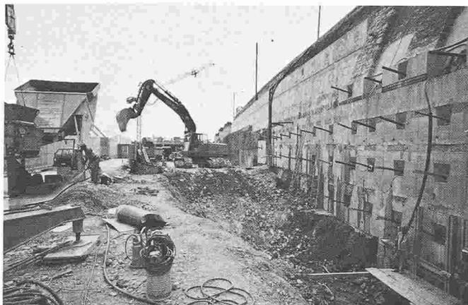
Sur 200 m, l'autoroute accolée à la falaise est bordée d'un long mur ancré profondément dans la roche, et dont l'épaisseur totale atteint par endroits 2 m. La place limitée à cet endroit, l'ampleur de l'ouvrage à réaliser et la densité du trafic qui continue de se dérouler derrière les palissades font de ce chantier un modèle d'efficacité.
