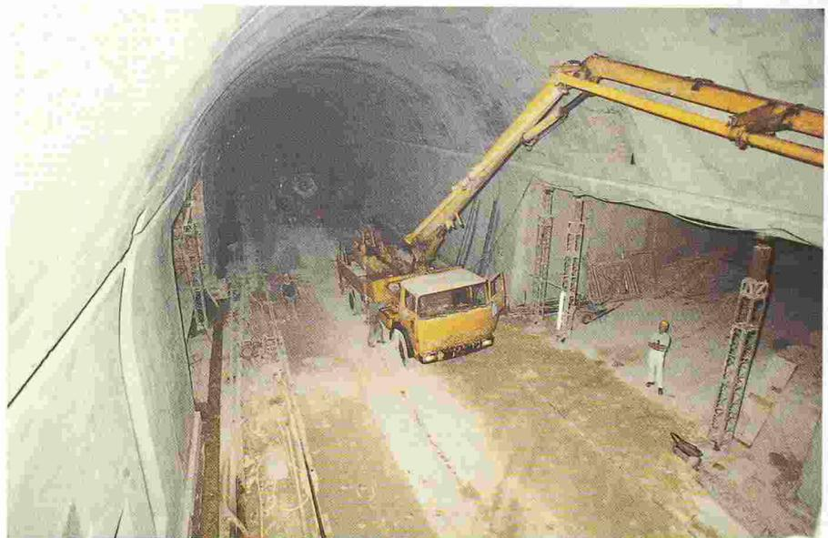
Tunnel est. Photo plongeante sur le tube sud avec une des galeries transversales, ainsi que le déploiement d'une conduite d'une béton-pompe pour le bétonnage de la dalle intermédiaire.
