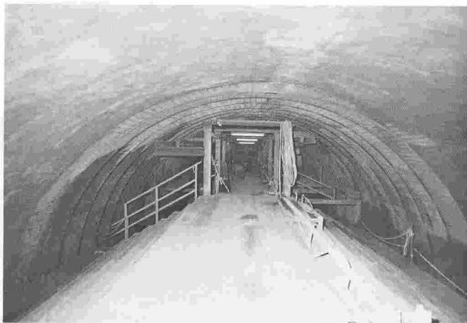
Tunnel est. Immédiatement derrière l'alésage  $\phi$  11,0 m, on consolide si nécessaire le tunnel à l'aide de boulons d'ancrage, de béton projeté, voire par la pose de cintres, de sorte que les autres opérations se déroulent sous une voûte déjà stabilisée.
