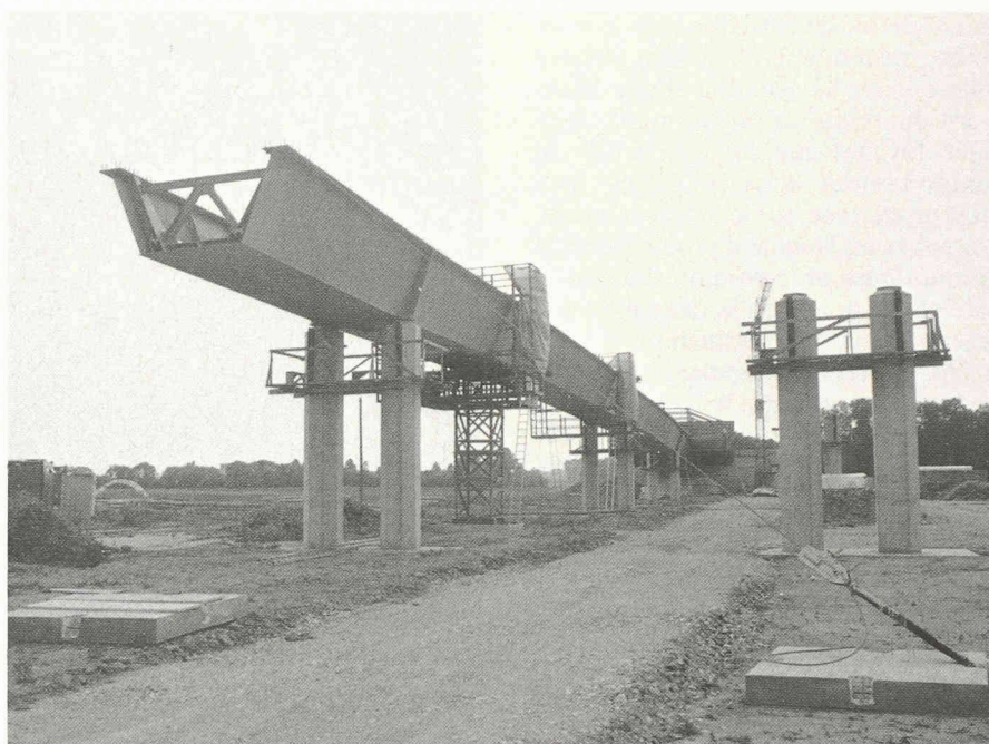
Fig. 4. – Viaduc du Bois-de-Rosset en construction.
