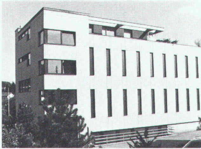
Bâtiment des télécommunications à Unterengstringen
