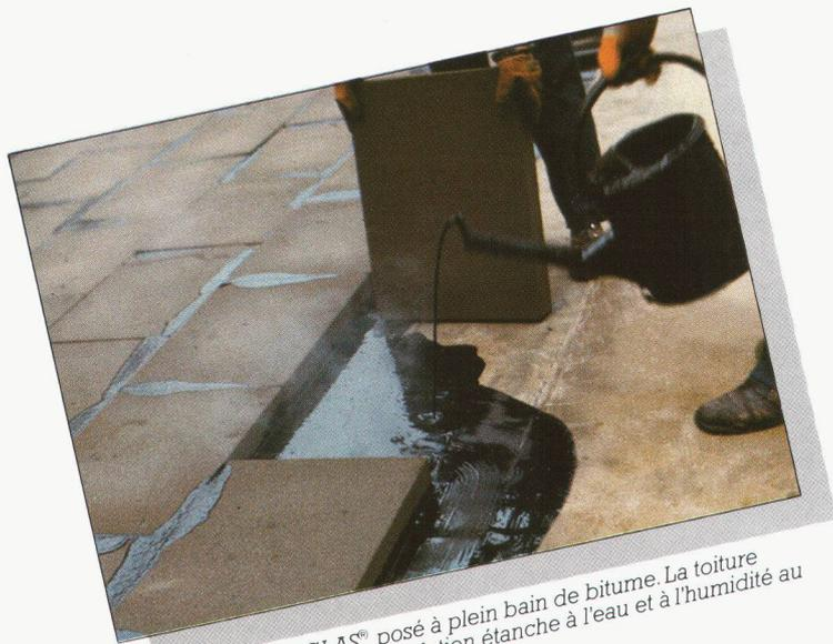
▲ L'isolant FOAMGLAS® posé à plein bain de bitume. La toiture "compacte" : un système d'isolation étanche à l'eau et à l'humidité au pouvoir isolant constant dans le temps.
