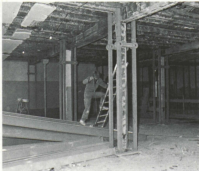
Fig. 5. — L'unité structurelle: la paire de poteaux.
