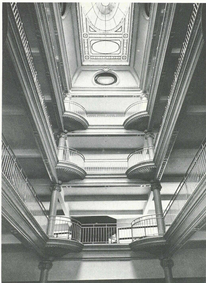
Fig. 9. — Vue des galeries intérieures du bâtiment en 1914. Les planchers, les sommiers, les piliers et les colonnes sont en béton armé.
