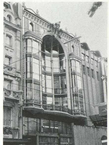
Fig. 7. — Vue de la nouvelle façade en 1985.
