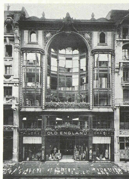
Fig. 4. — La façade du bâtiment n° 4, rue de la Croix-d'Or en août 1921. Il abrite alors une maison anglaise de tailleurs et drapiers. On observe la disparition des clochetons par rapport aux projets et esquisses.
