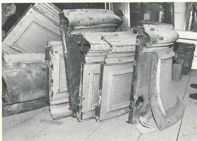
Fig. 16. — Les contrecœurs à l'origine en tôle galvanisée à moulures rapportées sont remplacés par des éléments en aluminium profilé, mis en forme sous presse.
