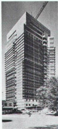
Revêtement de façade
