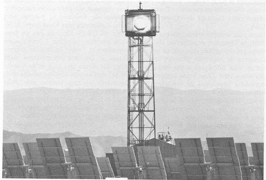
Fig. 1. — Héliostats et récepteur de la centrale solaire d'Almeria (Espagne).
