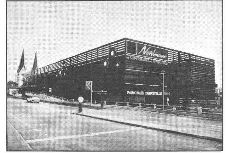
Parking à étages avec accès par rampes
