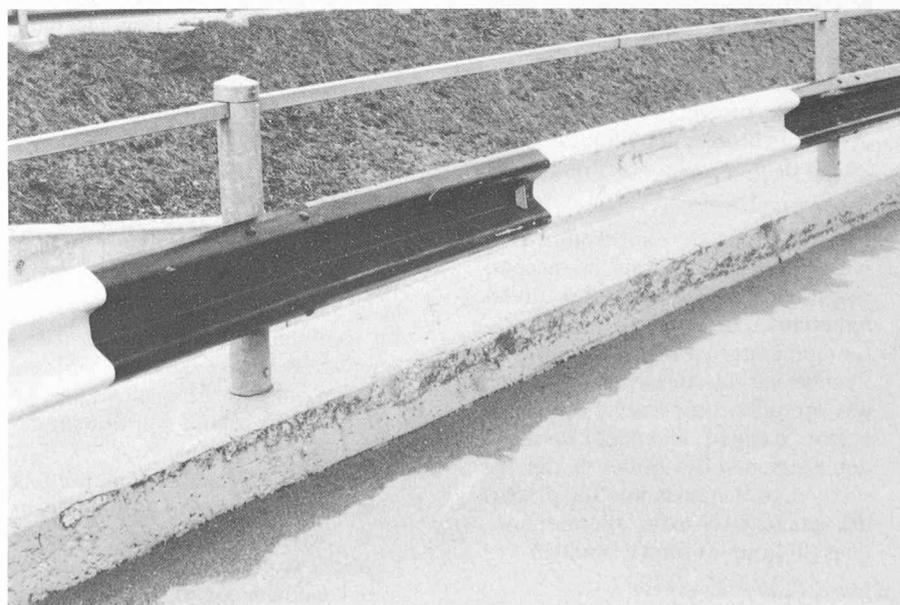
Fig. 1. — Protection de bordures endommagée par le chasse-neige.
