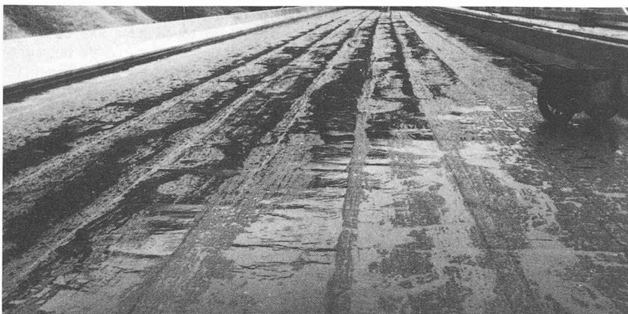
Fig. 8. — Les joints entre des feuilles à base de bitume modifié forment une retenue d'eau qui reste dans les pores de l'enrobé.
