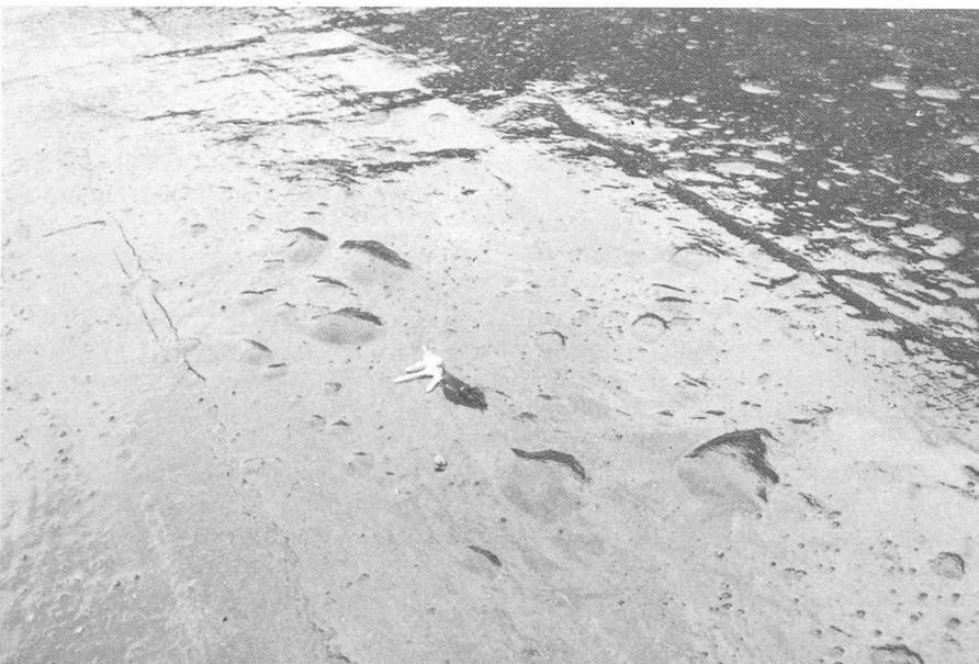
Fig. 3. — Bulles apparues sous une feuille préfabriquée à base de bitume modifié.
