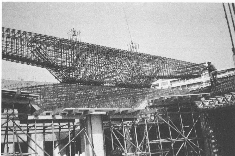
Fig. 14. — Armature préfabriquée.
