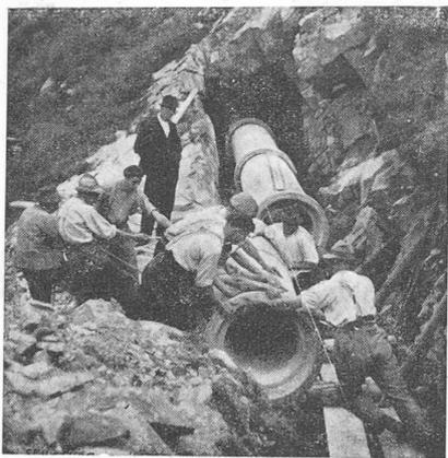
Fig. 2. — Adduction de la Reuse de Saleinaz. Conduite d'amenée en super-béton armé et centrifugé, reliant la prise au dessableur Dufour dans le rocher.
