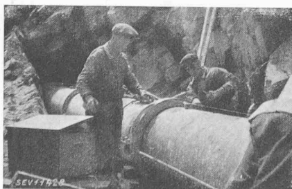
Fig. 3. — Adduction de la Reuse de Saleinaz. Exécution d'un joint de la conduite d'amenée en béton armé centrifugé.
