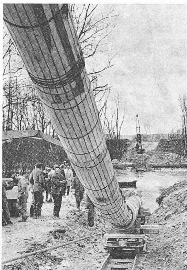
L'une des nombreuses traversées sous-fluviales de gazoducs en Suisse. On voit ici la pose du tube dans la Reuss.
