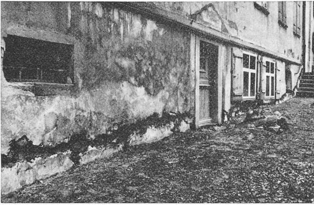
Fig. 2. — Maçonnerie fortement pénétrée d'humidité. Prise de vue durant le montage de l'installation électro-osmotique d'assèchement. Voir aussi figure 8.
