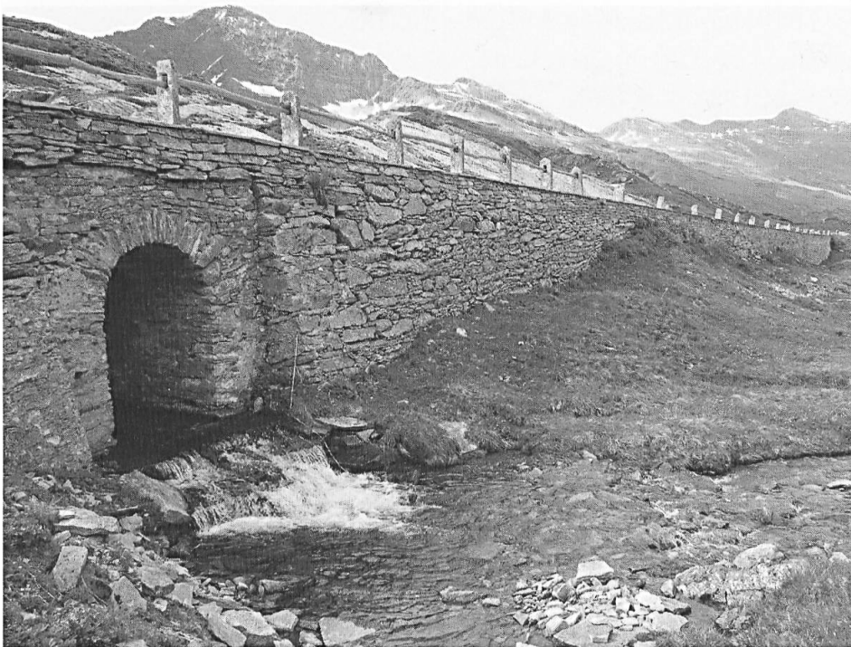
Ein vorbildlich saniertes Teilstück der Bernhardin-Strasse: Die Stützmauern, Wegbegrenzungssteine und der Wasserdurchlass (Tombino) konnten in ihrer traditionellen, für die Kommerzialstrassen charakteristischen Bauweise erhalten werden (Foto: Marco Marcacci).
