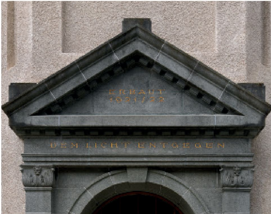
Krematorium, Giebel des Hauptportals mit Bauinschriften, Aufnahme 2012 (Foto: Javier Miguel Verme, Chur).
