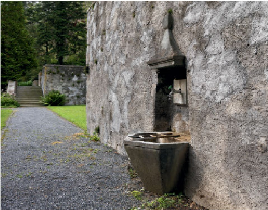
Murale Monumentalität: Stützmauern der oberen Ter- rasse mit Freitreppe im Hintergrund. Im Vordergrund expressionistischer Wand- brunnen. Aufnahme 2012 (Foto: Javier Miguel Verme, Chur).
