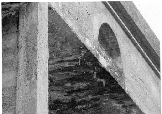
im Wesentlichen auf eine Ergänzung und Reprofilierung des beschädigten Betons konzentrieren. Wichtig ist eine kontrollierte Ableitung des Regenwassers. Heute fliesst es durch die halbkreisförmigen Aussparungen der Brüstung und durchnässt die Stirnen des Fahrbahnträgers wie die äusseren Partien des darunter liegenden Bogens. An diesen Stellen sind folgerichtig die grössten Schäden zu finden.
