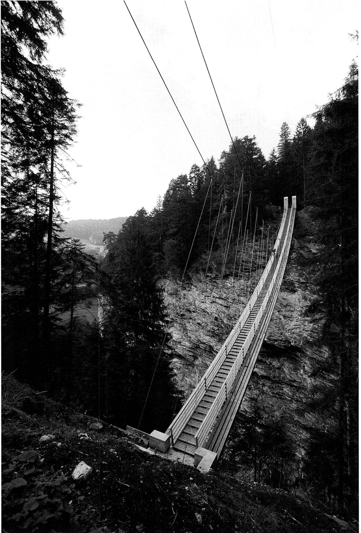
1996 wurde für die nördliche erste Etappe des Wanderwegs der Traversiner Steg als filigrane Holzkonstruktion erstellt, 1999 für die Fortsetzung durch den südlichen Teil der Schlucht die Pünt da Suransuns als Spannbandbrücke, deren Gehweg mit Steinplatten aus Anderer Granit konstruiert ist. Der unterschiedlichen Materialisierung der beiden Brücken in Holz und in Stein liegt die Idee zugrunde, damit die Kulturscheide zwischen Nord und Süd zu markieren.
