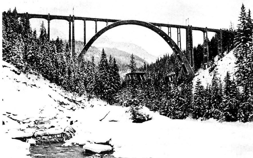
Abb. 1. Langwieser Viadukt. Aus armiertem Beton; Firma Züblin & Cie., Zürich. Gesamtlänge 285 m.
