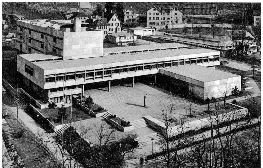
Bündner Lehrerseminar (am Plessurquai), genannt Haus Cleric, Sicht vom Altersheim Bodmer aus, Zustand um 1965. (Quelle: Archiv Hochbauamt Graubünden)
