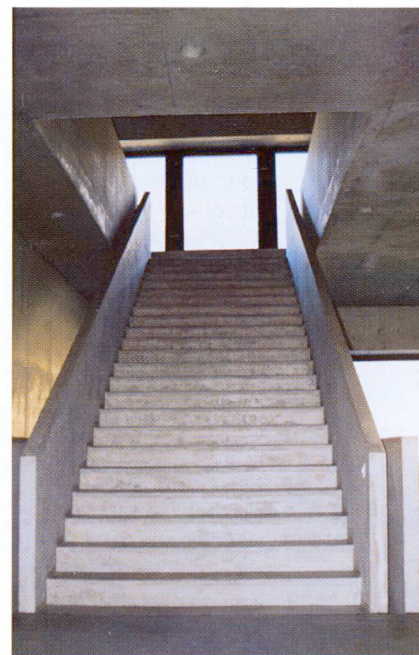
Montée au premier étage.
