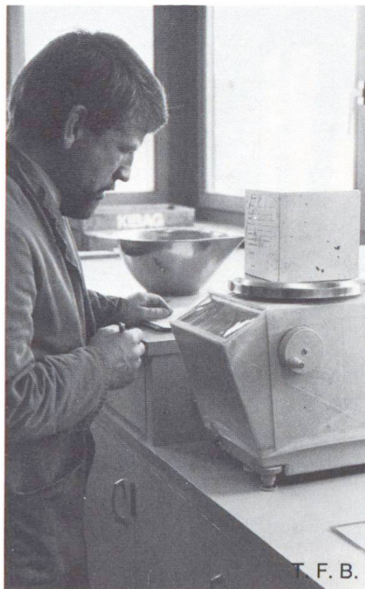
Détermination de la densité du béton durci
