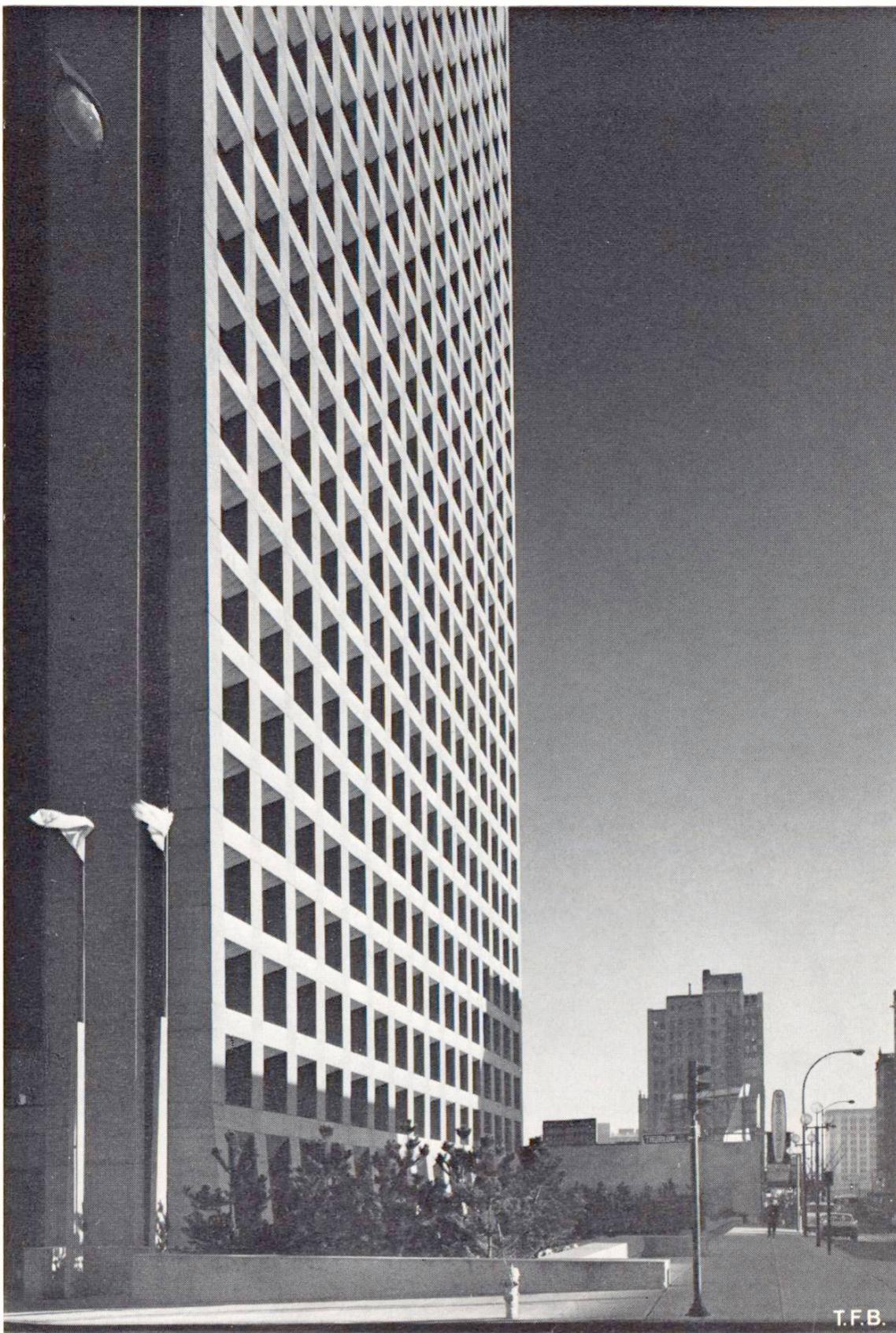
Fig. 2 Cette vue donne une bonne idée du monolithisme de la façade. Les éléments horizontaux et verticaux sont identiques avec partout une largeur de 90 cm à l'extérieur. Les fenêtres carrées de 2,15 m de côté sont placées en retrait et paraissent avoir été estampées.
