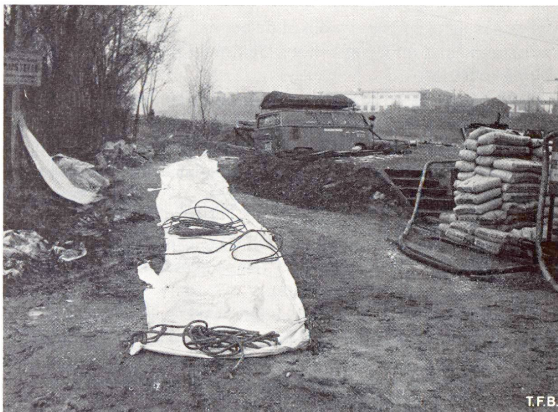
Fig. 1 Container Colcrete avant la pose. Enveloppe en tissu de 1,50 m de large et 20 m de long.
