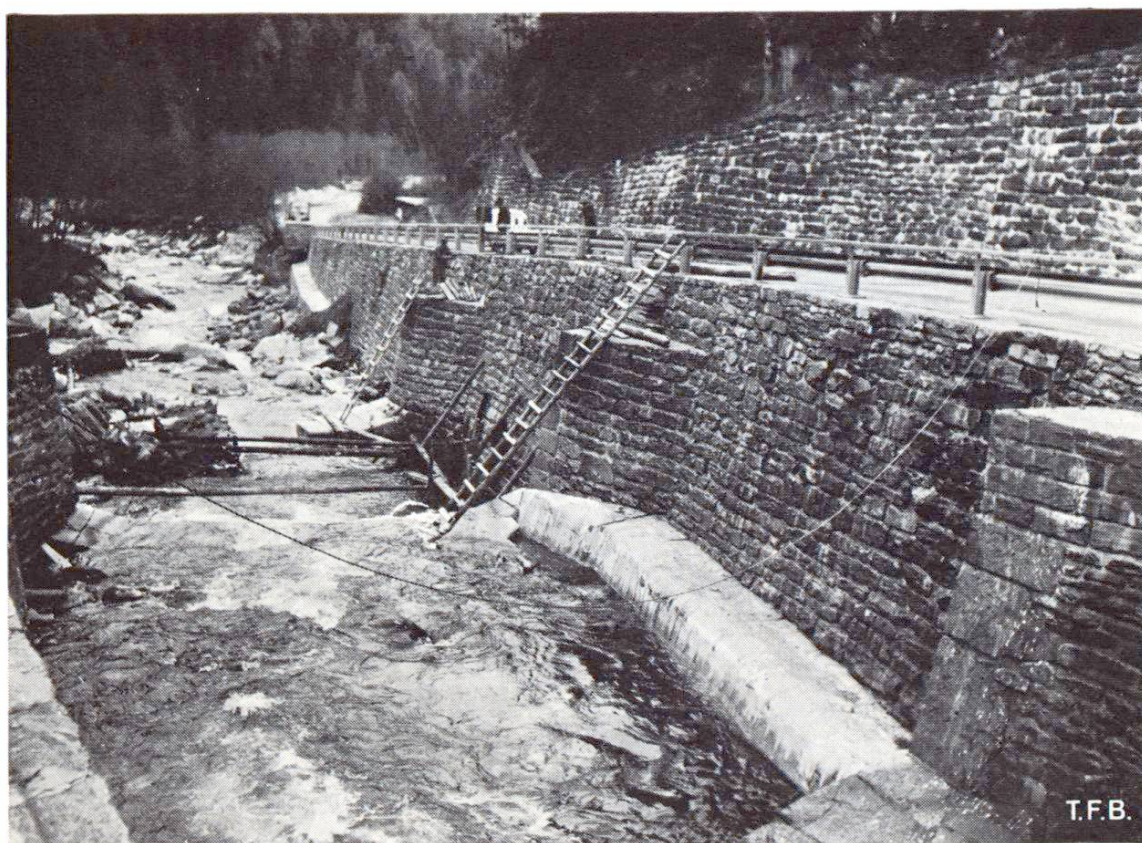
Fig. 5 Container Colcrete après remplissage au pied du mur de soutènement et après enlèvement du coffrage auxiliaire.
