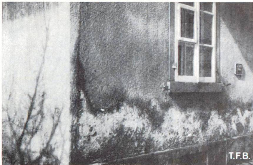
Fig. 4 Colorations et efflorescences imputables à un manque d'isolation horizontale
