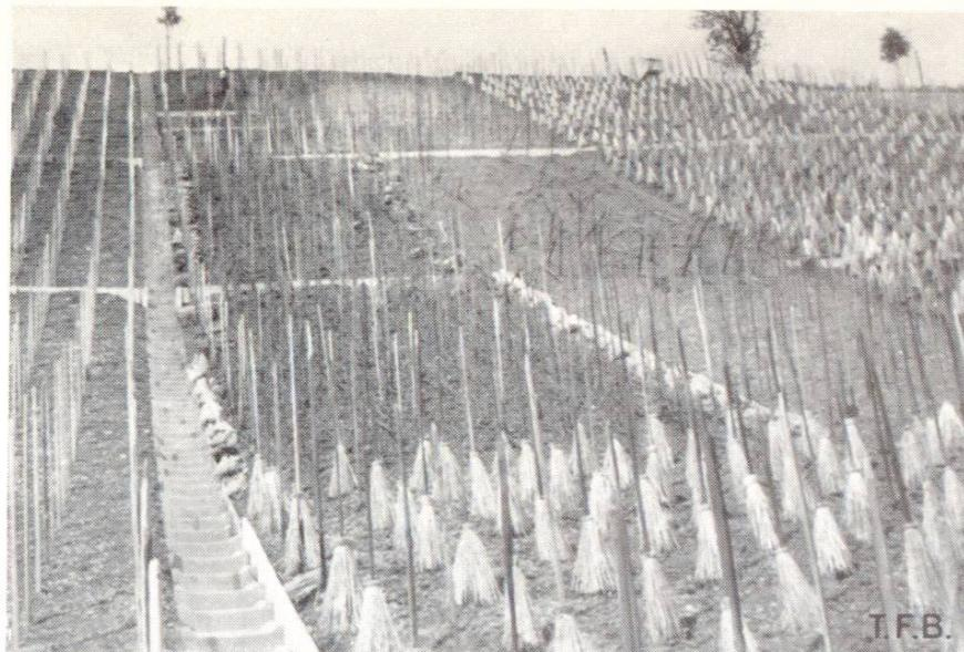
tenus, ce qui n'est pas le cas pour les constructions en béton. Les pluies d'orage déposent, dans les fossés en béton, les terres qu'elles ont entraînées, puis s'écoulent décantées vers les escaliers-coulisses et les canalisations en tuyaux.
