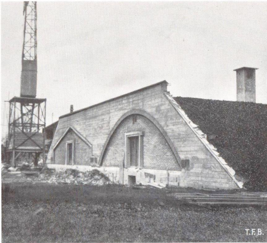
La fig. 1 donne le profil d'une petite cave voûtée construite en éléments de béton moulés d'avance.
