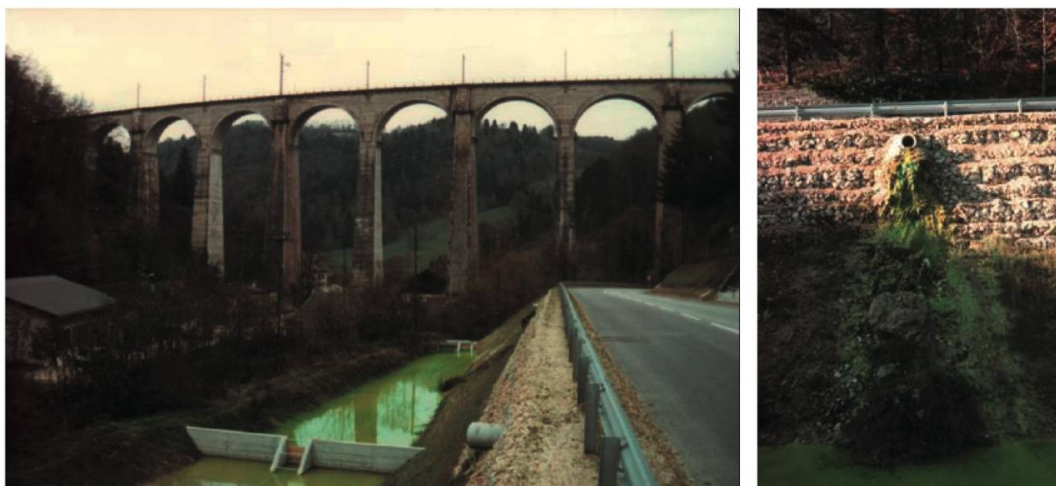
Fig. 14: Essai de coloration du 7 novembre 1995 et réapparition du traceur fluorescéine 2 h après l'injection.
