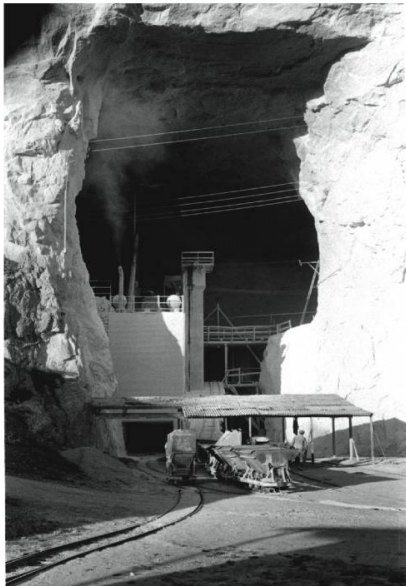
Fig. 11: Installation de concassage et silos (photo des années 50).
