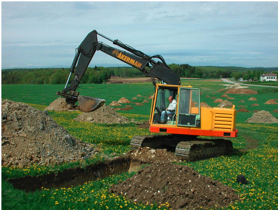
Fig. 8: Sondage réalisé à la pelle mécanique.
