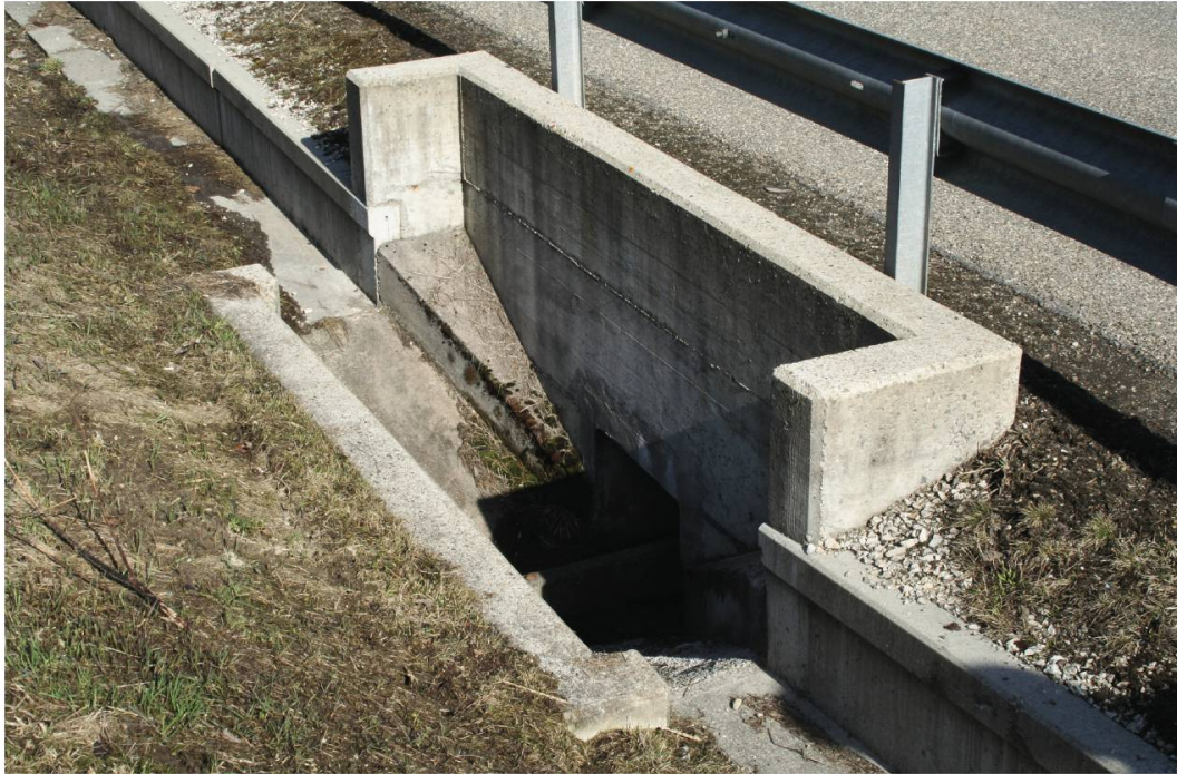
Fig. 3 : Détails de l'aménagement d'un crapauduc
