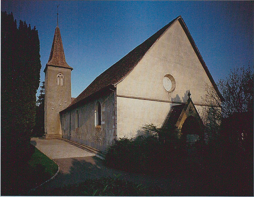
L'église et la tour vues du nord-ouest.
