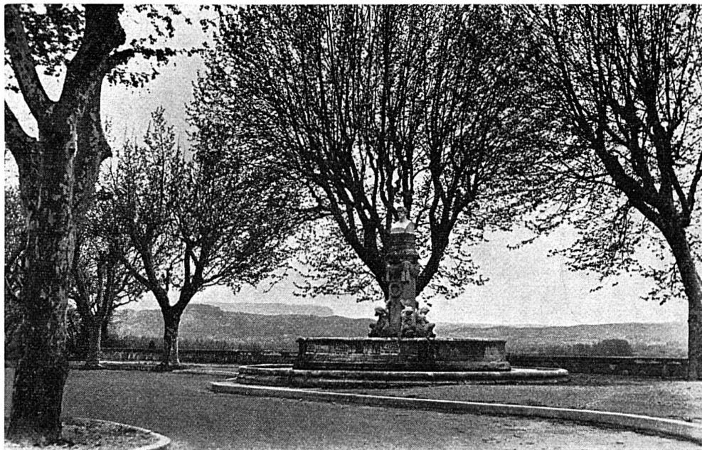
Fontaine Morel, sur le Cours de Pertuis.
