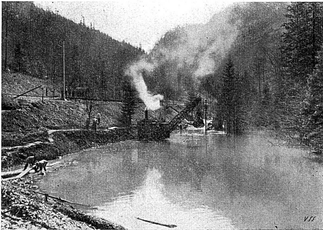
L'excavateur au travail
