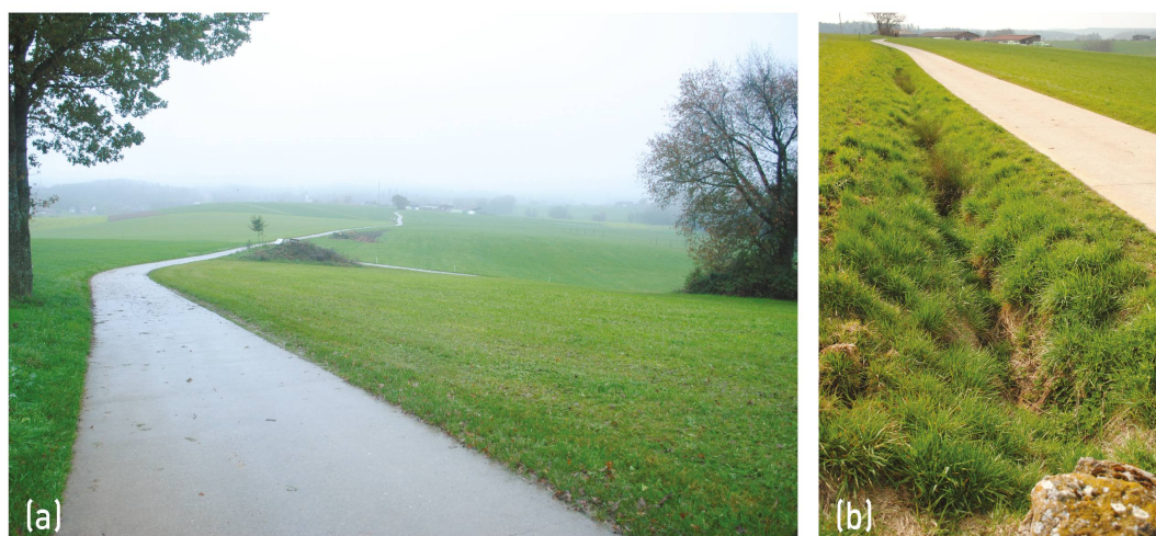
Fig. 10. (a) Le chemin longeant le sud du marais est pentu et fait de dalles en béton sur un coffrage. (b) Sa partie aval est bordée d'un fossé qui collecte les eaux. Les eaux sont redirigées vers le marais par un tuyau sous la route, donc de manière concentrée (cf. figures 5 et 7a).
