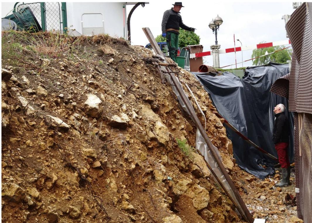
Fig. 8: Talus de la fouille pour le nouvel immeuble à la rue des Vergers (coordonnées 593 515/246 567).
