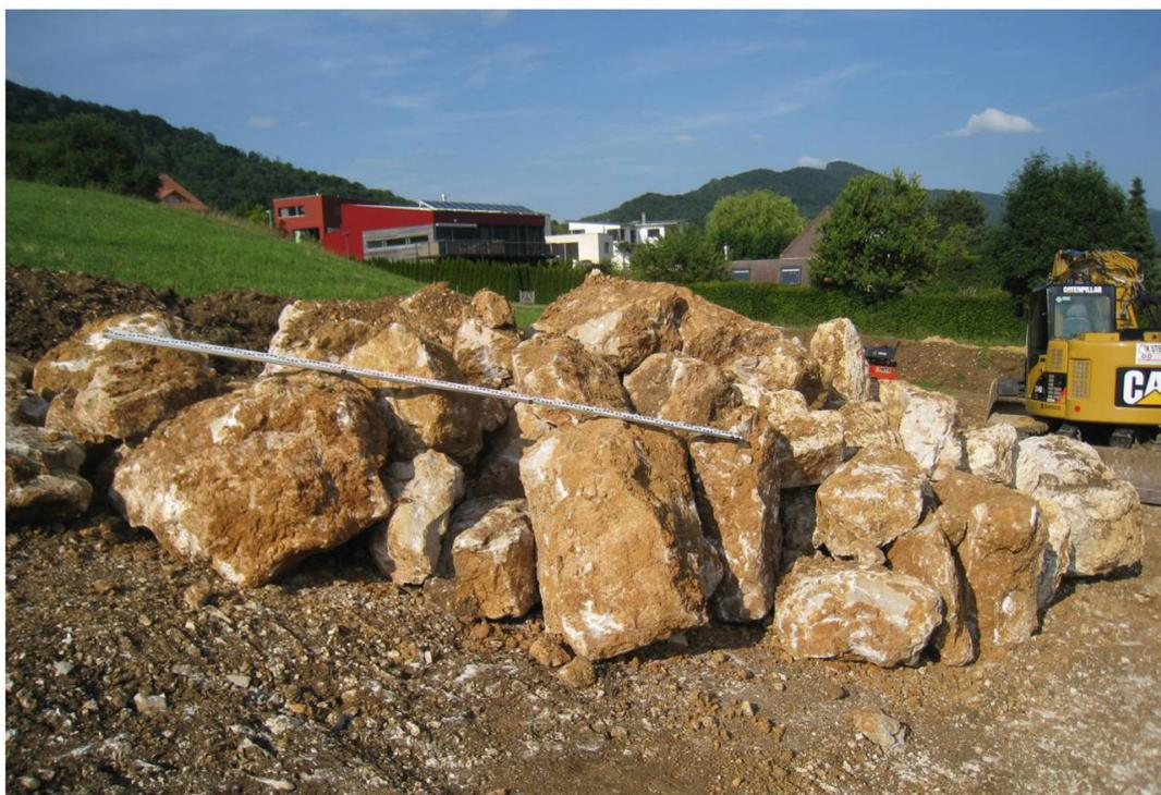
Fig. 9: Blocs calcaires anguleux (Malm) retirés de la fouille à environ 30 m à l'ouest du sentier Henri-Parrat (coordonnées 593 025/246 910).
