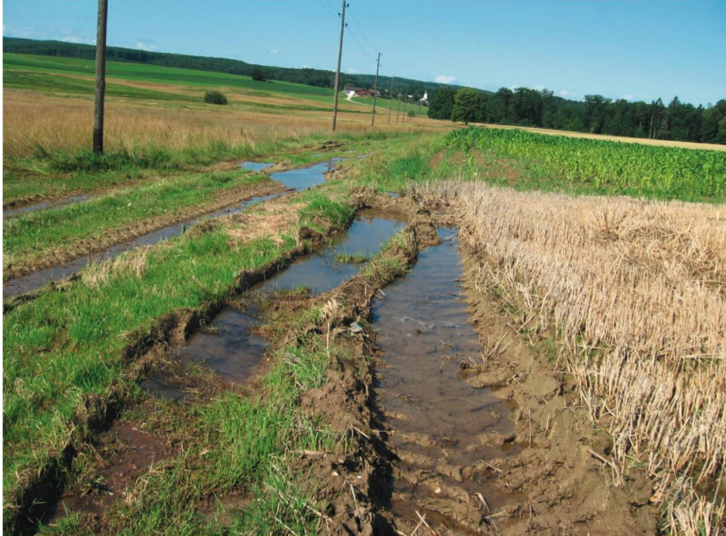
Fig. 3 : Le tassement du sol le déstructure ; les ornières canalisent l'eau ; la zone tampon ne peut plus jouer son rôle d'assainissement. (Photo : Jean-Pierre Egger, le 7 juillet 2012)
