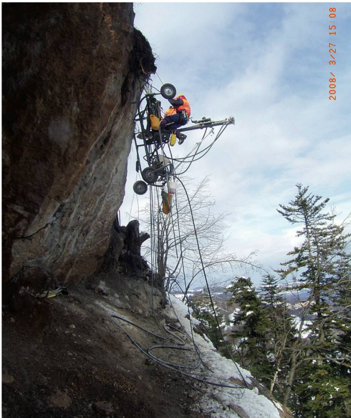
Figure 8: forages pour les clous dans la niche d'arrachement.
