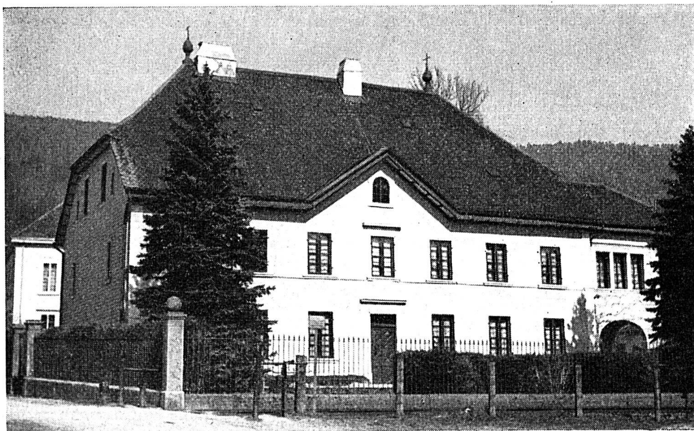
La maison Morel à Corgémont
