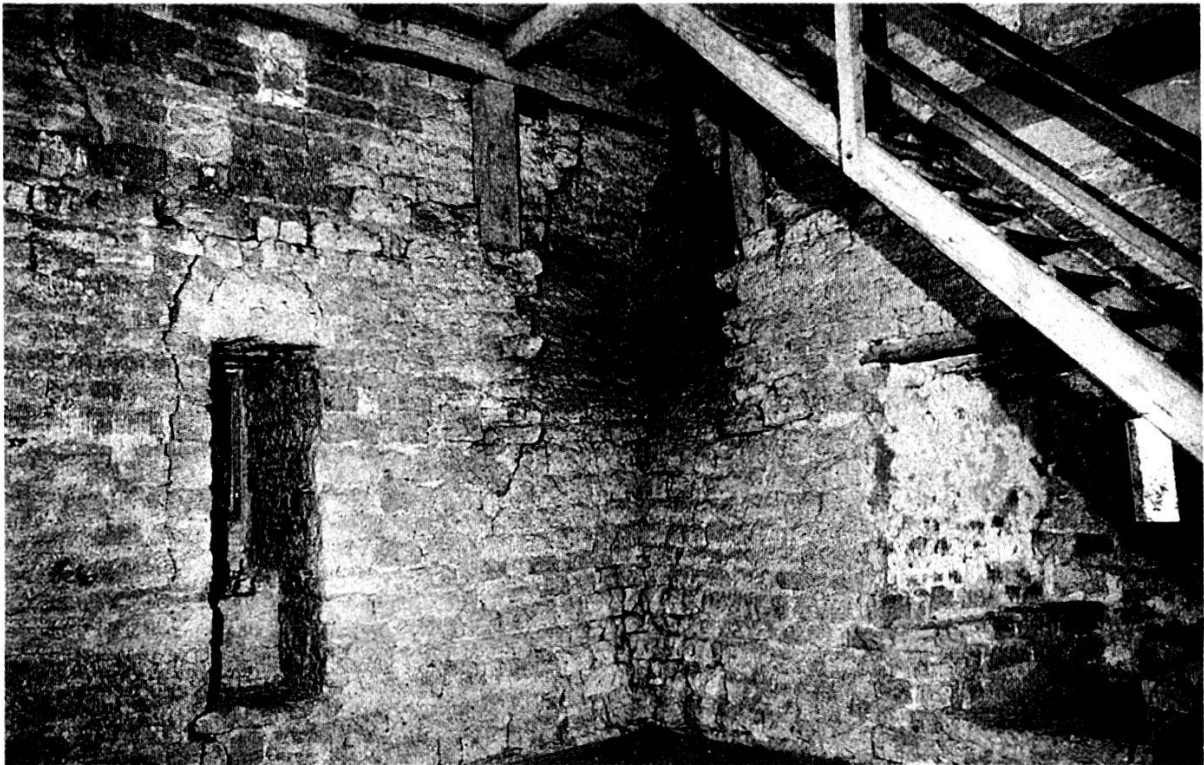
Abb. 8: Grosser Turm, Kamin im 1. Obergeschoss. Foto Aargauische Kantonsarchäologie, Theo Frey.
