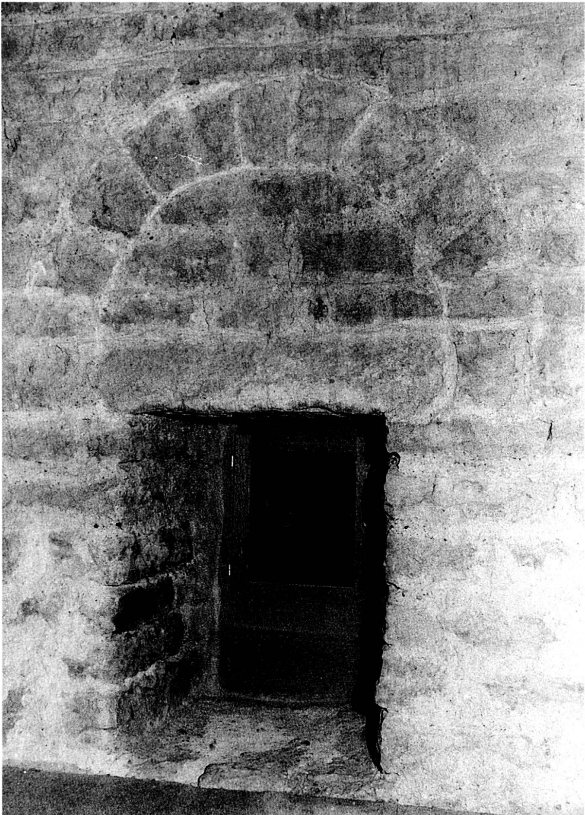
Abb. 9: Grosser Turm, steinsichtig verputztes Handquadermauerwerk der Erdgeschoss südwestwand. Foto Aargauische Kantonsarchäologie, Theo Frey.
