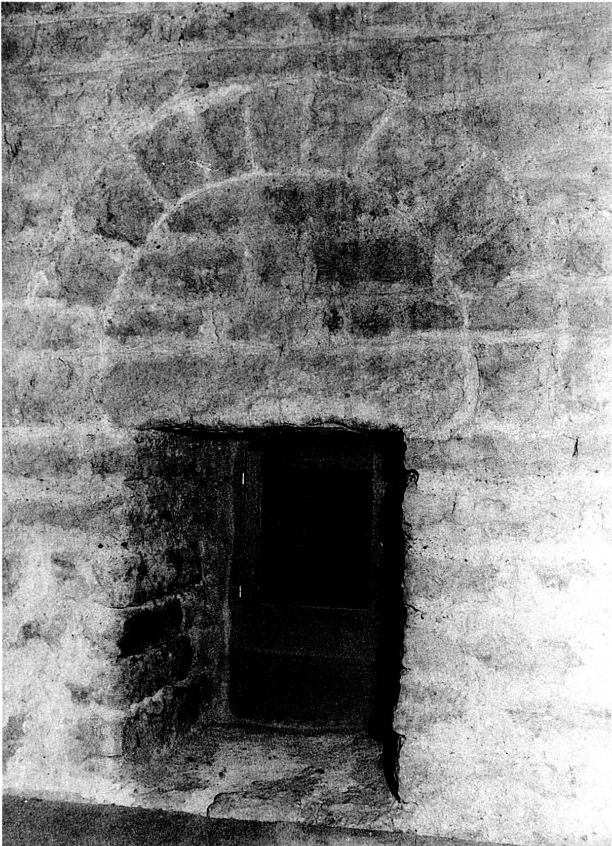
Abb. 9: Grosser Turm, steinsichtig verputztes Handquadermauerwerk der Erdgeschoss südwestwand.
