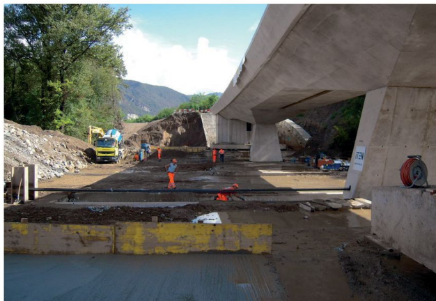
A sinistra, costruzione del nuovo ponte a lato del vecchio manufatto in muratura; a destra, nuovo ponte e, in primo piano, preparazione del terreno di fondazione della spalla
